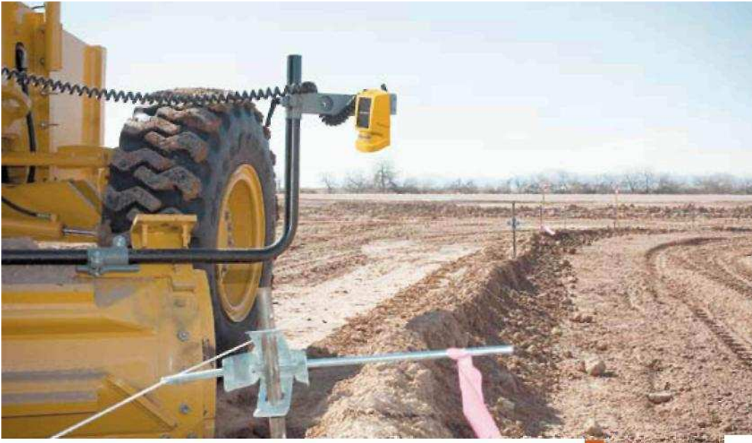
Работа на автогрейдер с установленной системой GCS600 с ультразвуком, г. Ставрополь
